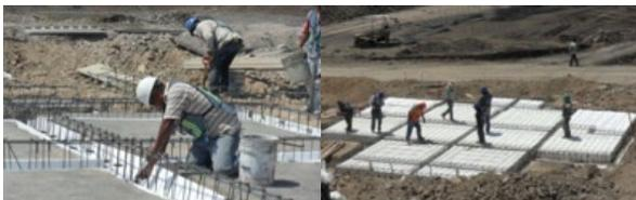
Colado con concreto de muros y losas de entrepiso
