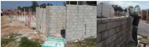
Segundo edificio. Construcción con muros de tabique extruido multiperforado
