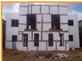
Colocación de poliestireno expandido (EPS).
