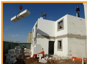
Instalación de block de concreto celular.
