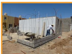
Colocación block de concreto tradicional.
