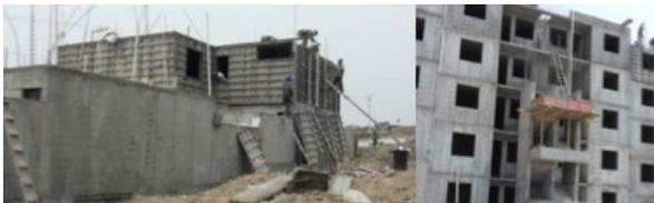
Instalación de placas de poliestireno expandido (EPS) en los muros exteriores
