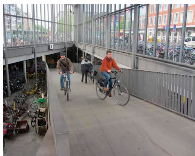
Figura 45: Estacionamiento para bicicletas y estación de servicio en Muenster (Alemania). ©Mathias Merforth, 2013
