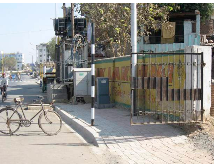
Figura 32: La infraestructura inadecuada para peatones y ciclistas debe ser abordada por los planes de Movilidad Urbana.
