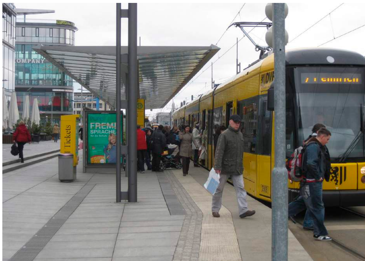
Figura 22: Estación de tren ligero sin barreras en Dresden (Alemania). ©Stefan Belka, 2009
